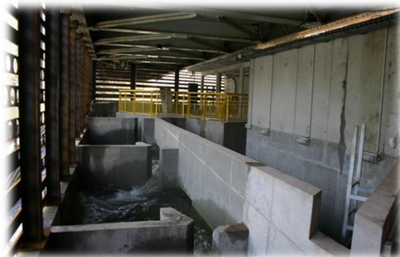
**Figure 3 : Passe à bassins successifs du barrage du Breuil-en-Auge**
