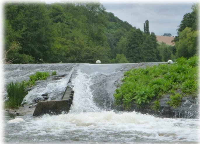
**Figure 13 : Passe en écharpe (barrage du Pont de la Mousse)**
