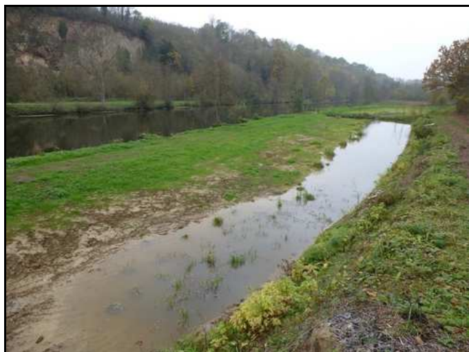
Figure 10 : Végétation après travaux
